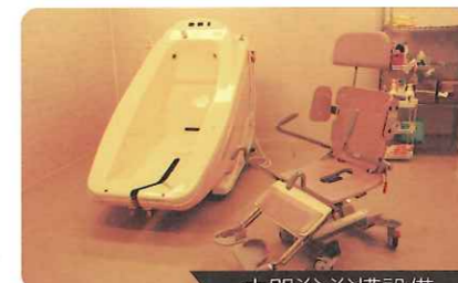
中間浴・浴槽設備
